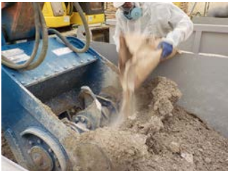
写真 3 不溶化材投入状況
