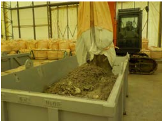
写真 2 廃石膏投入状況
