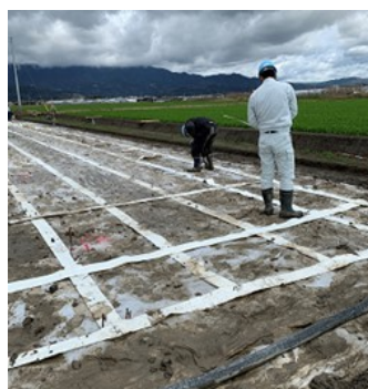
写真-1.(a)敷設状況
