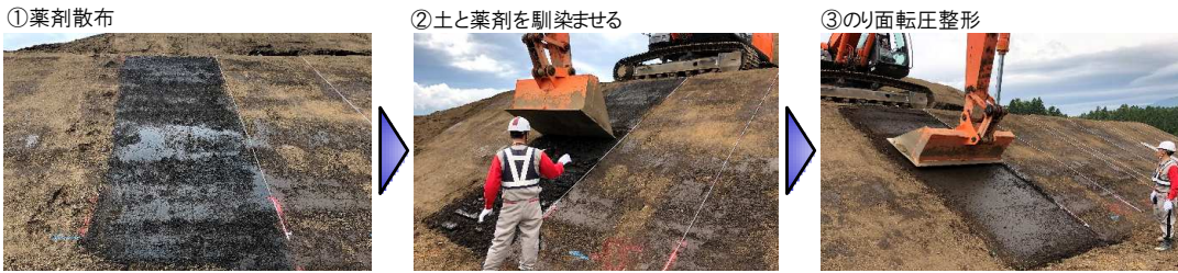
写真-2 施工方法の新たな試み
