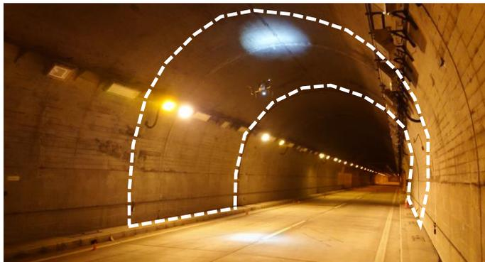
図3 ドローンの飛行状況と撮影範囲
