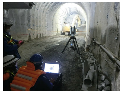
写真-3 ブレーカーに設置したターゲットの追尾測定状況
