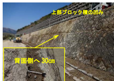
写真-3 ブロック積のくぼみ
