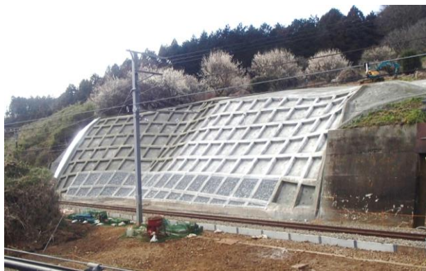
写真3 土留壁崩壊現場の復旧工事（のり面工）
