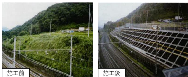
写真1 降雨防災強化対策の一例（のり面工）
