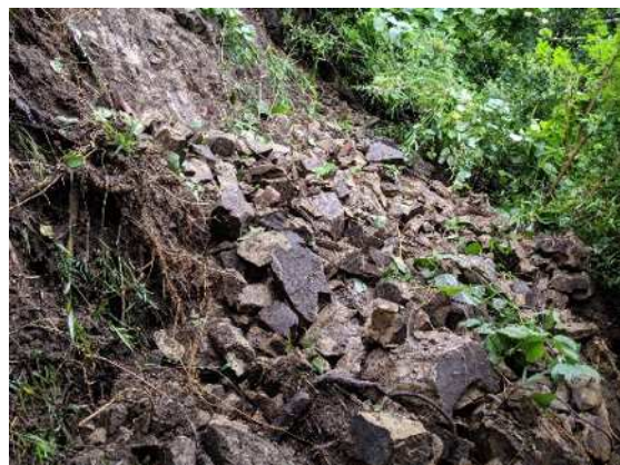
写真-1 崩壊状況
