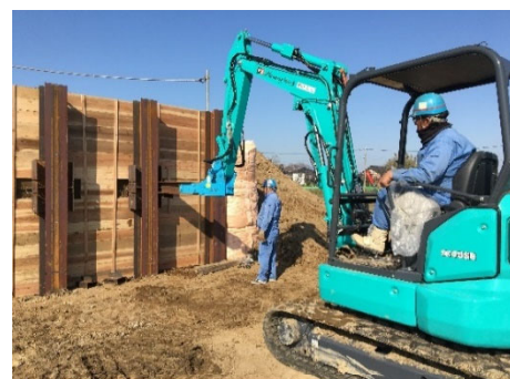
写真-2 水平杭挿入状況
