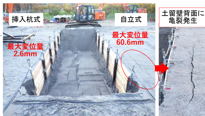
写真-1 実験実施状況(掘削深さ2m時)
