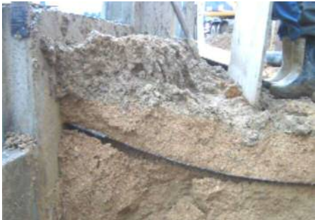
写真 2 開削した補強材の状況
