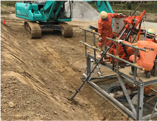
写真-1 施工状況写真(地盤:砂質盛土)
