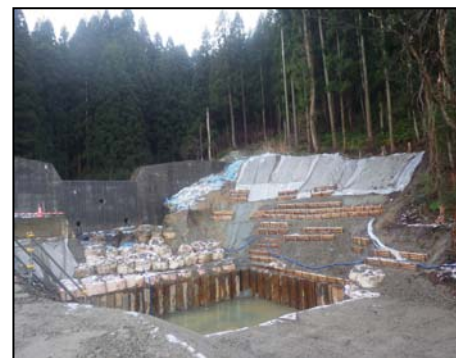
図-6 掘削工事完了全景
