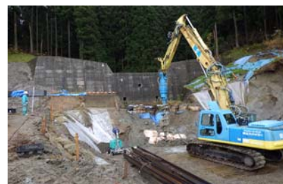
図-4 オーガ装着先行削孔
