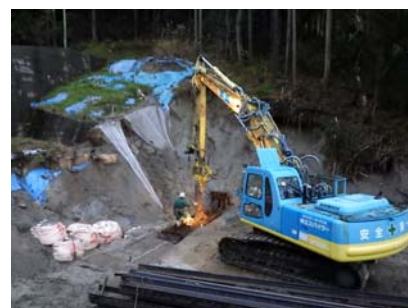
図-5 鋼矢板打設
