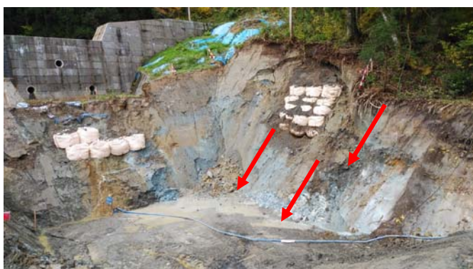
図-1 床固工掘削完了直後現況
