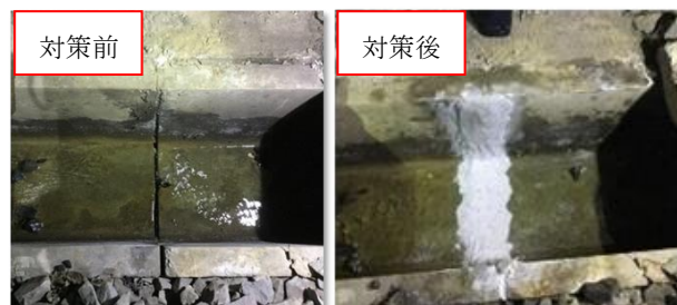
写真-4 対策工一部実施前後状況
