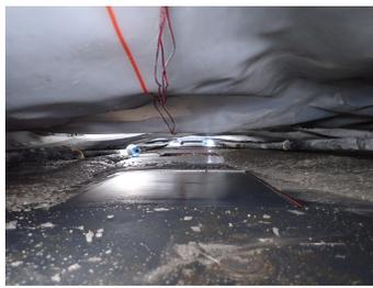
写真-1 天端最頂部水平打設状況
