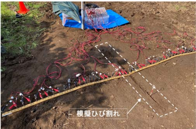
図-4 屋外電気探査試験実施状況（模擬ひび割れ幅 4mm）
