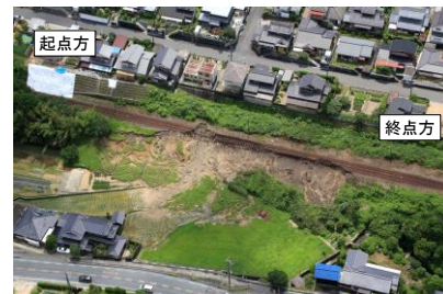
図 1 被災状況の写真
