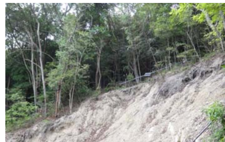
写真-1 現場状況
