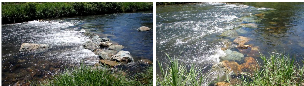
写真3 石組み帯工を設置したことによる多様な流れの流況
