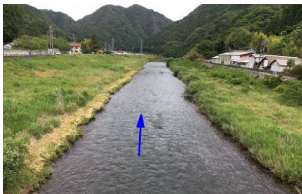
写真1 神戸川で直線河道された状態
