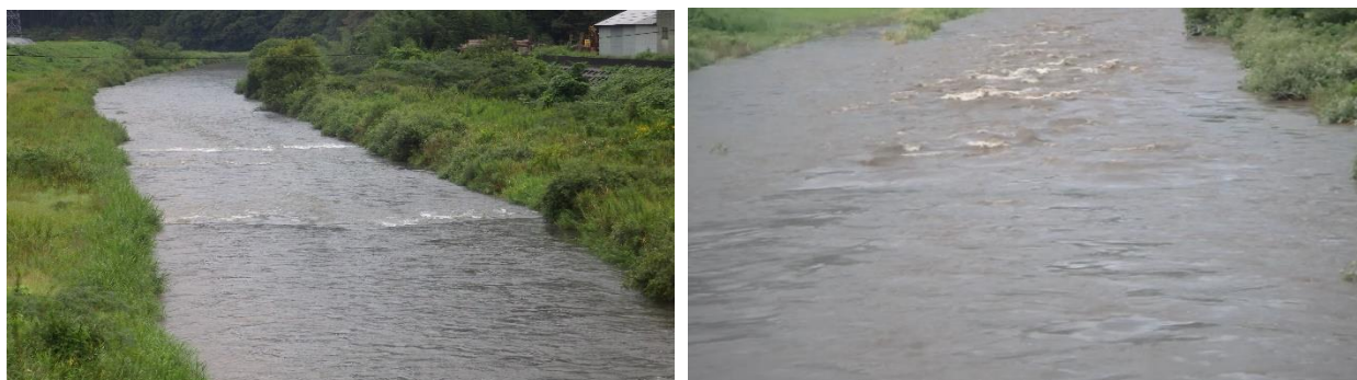
写真4 石組み帯工周辺の増水時（左側の写真）および小規模の洪水時（右側の写真）の流況
