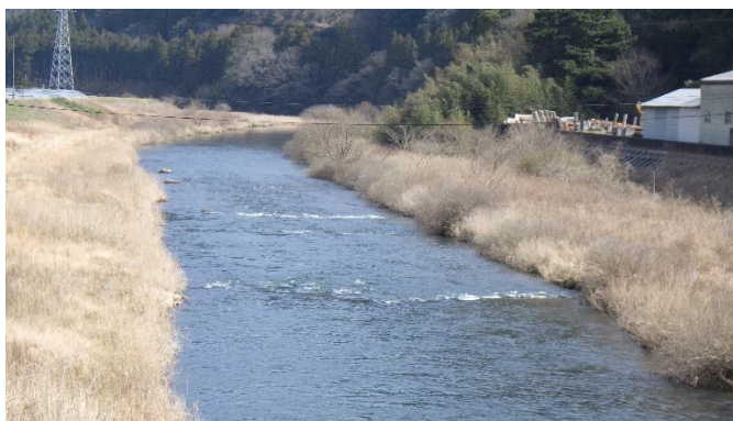
写真2 石組み帯工で直線河道を改善した状態
