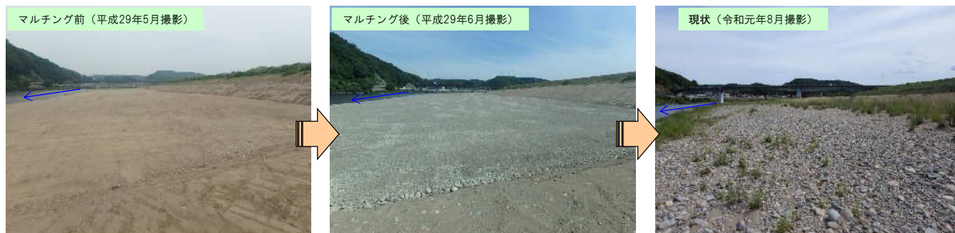
図 5 安富地区の掘削箇所におけるマルチングの実施状況及び経過状況
