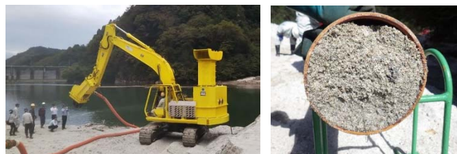
図-2 片桐ダム現場実験
