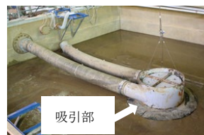
図-3 潜行吸引式排砂管(φ300mm)の設置状況
