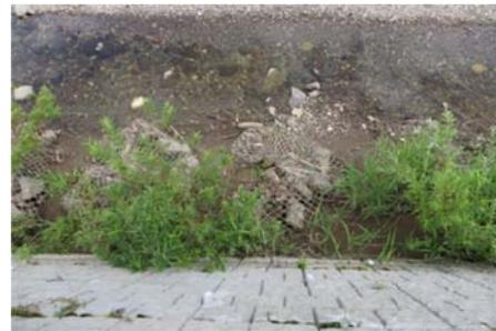
写真 1 根固め用袋材(FU)に堆積した土砂
