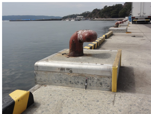
図-3 鮎川漁港の係留杭 (2020年3月27日撮影)
