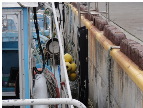
図-5 岸壁に設置されたタラップ（泊漁港）
