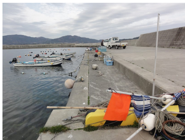
図-4 階段状の岸壁（要谷漁港）
