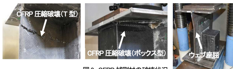
図 3 CFRP 補剛材の破壊状況
