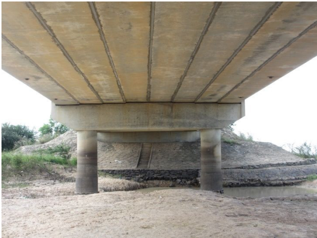
写真-1 下部工正面および桁裏
