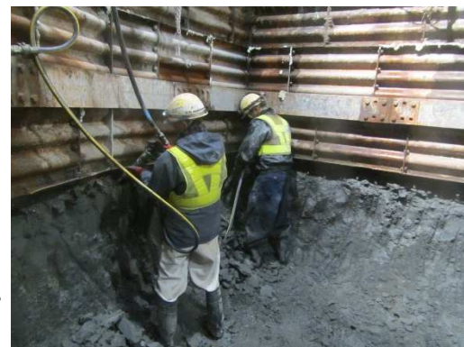
写真-1. 泥岩層自立状況
