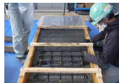
写真-1 UHPFRC の打込み状況
