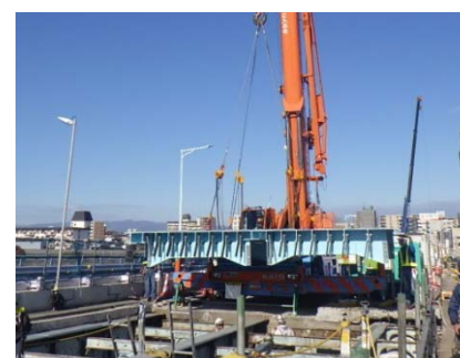
写真-4 鋼床版架設
