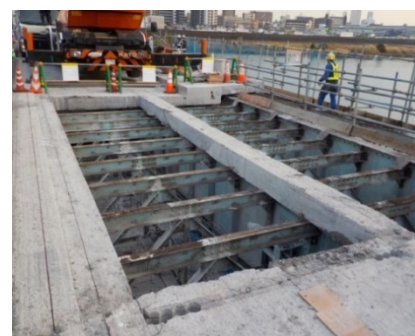
写真-3 床版ブロック撤去後
