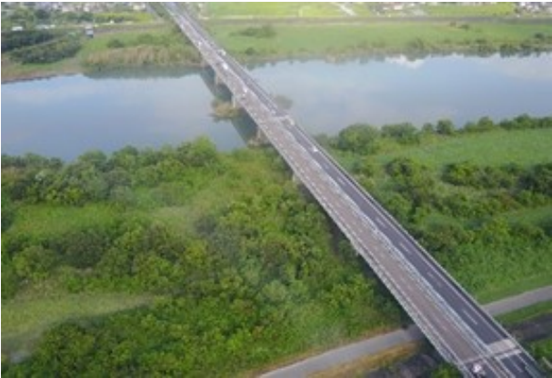
写真 1 長良川橋全景
