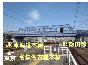
写真-1 架橋状況
