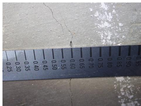
写真-2 自動検出手法で最大ひび割れ幅が確認された箇所（ひび割れ f)）
