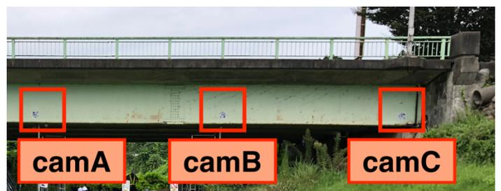
図 2. マーカー(target)取り付け位置
