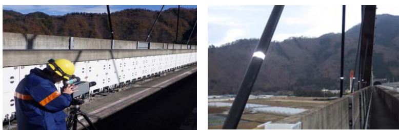
写真－2 測定状況
