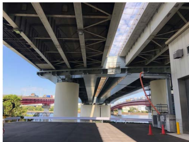
図 1 計測対象橋梁
