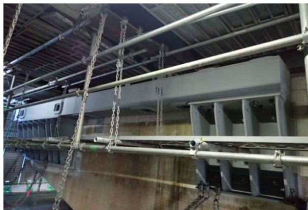
写真-1. ジャッキアップ受梁設置状況
