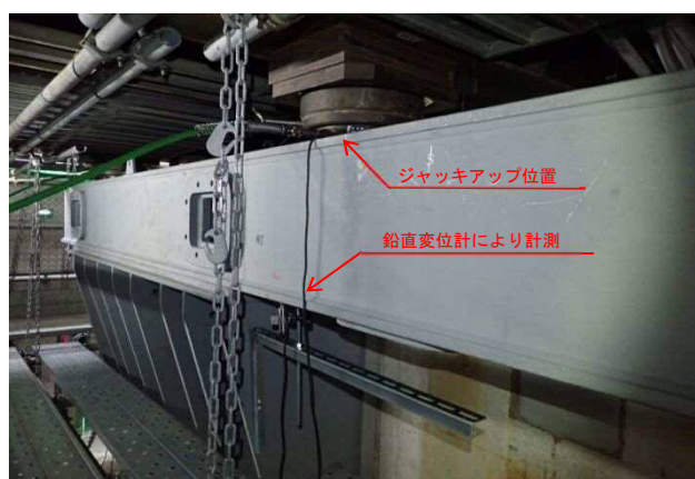
写真-2. ジャッキ点における鉛直変位計測状況
