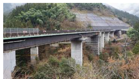
写真－1 橋梁外観
