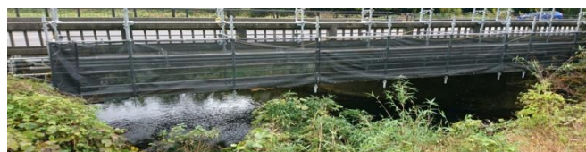
図1 計測した橋梁添架設備(全体)
