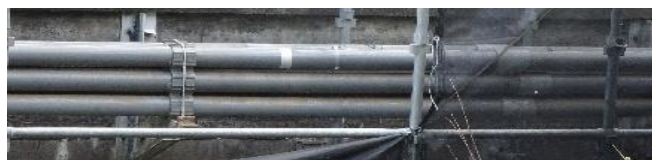
図2 計測した橋梁添架設備(拡大)
