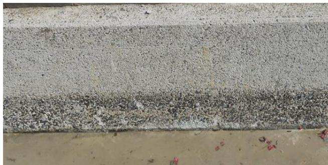
図-1 摩耗が進行した水路コンクリート壁面
