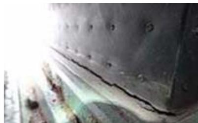
写真-1 き裂の入ったゴムダンパー
