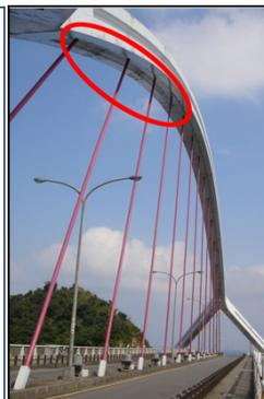
図-6 定着部の構造 写真-3 斜材定着点<sup>4)</sup>
