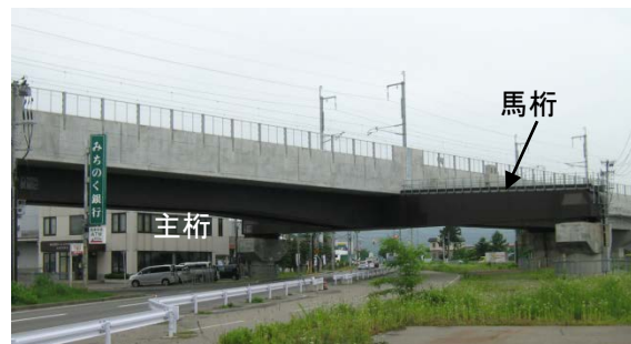
写真 1 馬桁付連続合成桁(事例)
