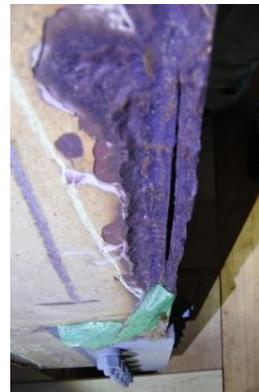
写真-1 腐食切れの一例
