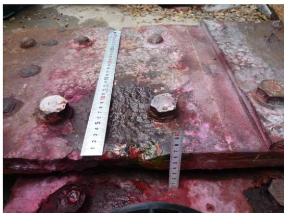
写真-1 ガセット取り付け部の腐食状況(e-e断面)
