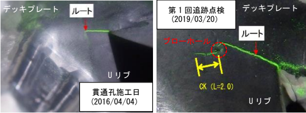
(b) SFRC 補強後に貫通孔を施工した事例（H 橋）
