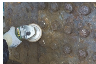
写真1 フラット型ダイヤモンド工具による素地調整状況
