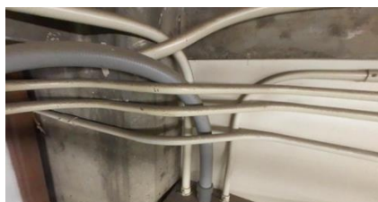
図-3 撮影対象の配管
