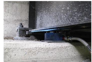
図-8 ジャッキ桁仮受け状況
