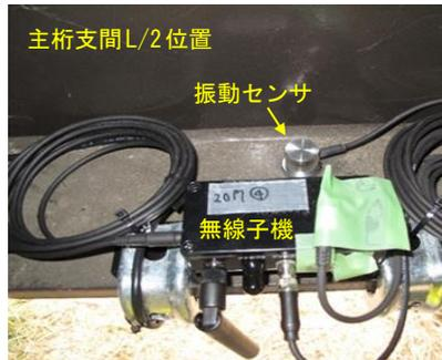
図-5 振動センサ設置状況
