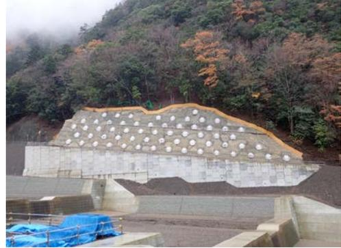
写真-1 法面補強グラウンドアンカー
