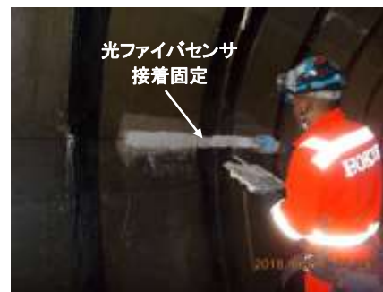
写真-2 打継目用センサの設置
