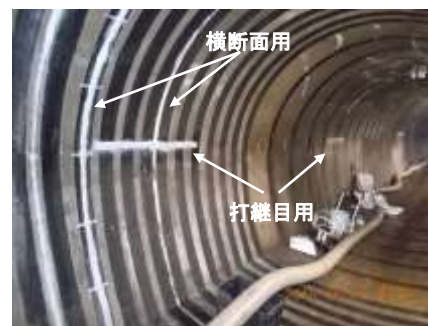
写真-3 センサ設置後の状況
