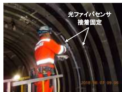
写真-1 横断面用センサの設置
