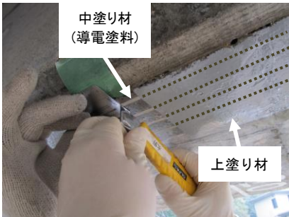
写真2 スリット施工
