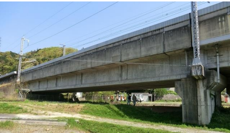
写真 1 対象橋りょうの外観
